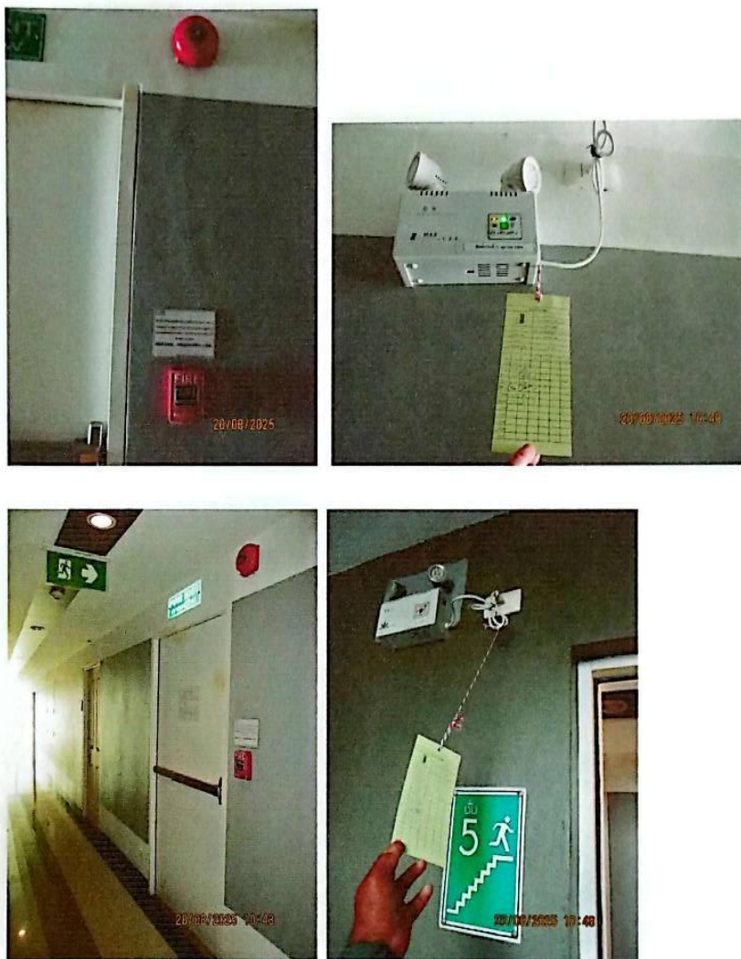
รูปที่ 3 แสดงอุปกรณ์แจ้งเตือนด้วยมือ อุปกรณ์ส่งสัญญาณเสียง ไฟส่องสว่างฉุกเฉินและป้ายบอกทางหนีไฟ ข้อตรวจพบ อุปกรณ์แจ้งเตือนด้วยมือ, อุปกรณ์ส่งสัญญาณเสียง, อุปกรณ์ส่องสว่างฉุกเฉินและป้ายบอกทางหนีไฟ พร้อมใช้งาน
